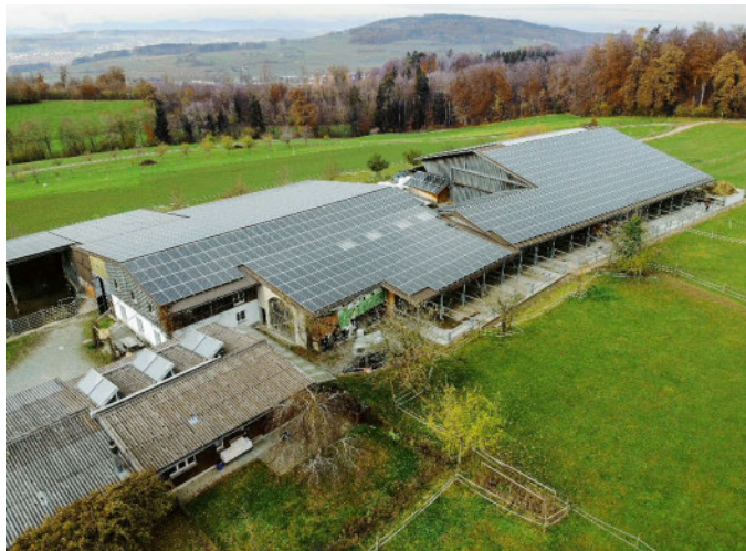
Der Erushof mit der PV-Anlage mit 404 kW Maximalleistung
